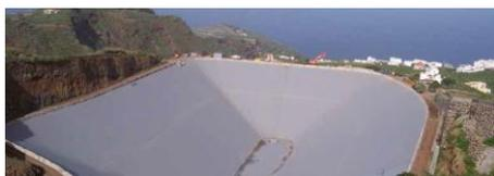
Geomembrana omogenea a base di cloruro di polivinile flessibile (PVC-P), grigio scuro, idonea per lavori idraulici quali bacini, canali, dighe, riserve idriche e antincendio. Alta stabilità ai raggi UV.
