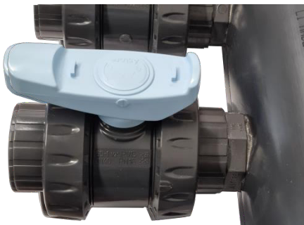
Particolare attacco valvola selettiva
